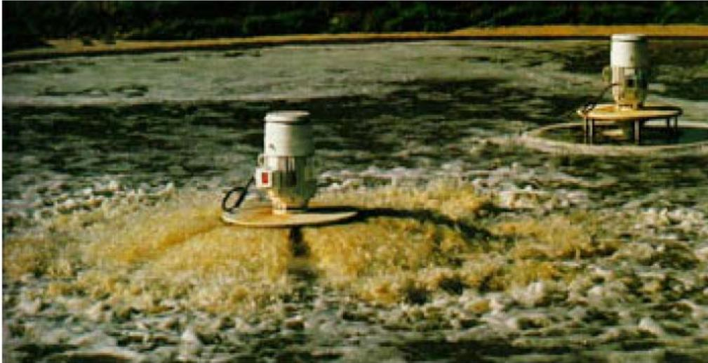
圖 2 後曝氣處理在於使溶氧量限制保持於 6mg/l
