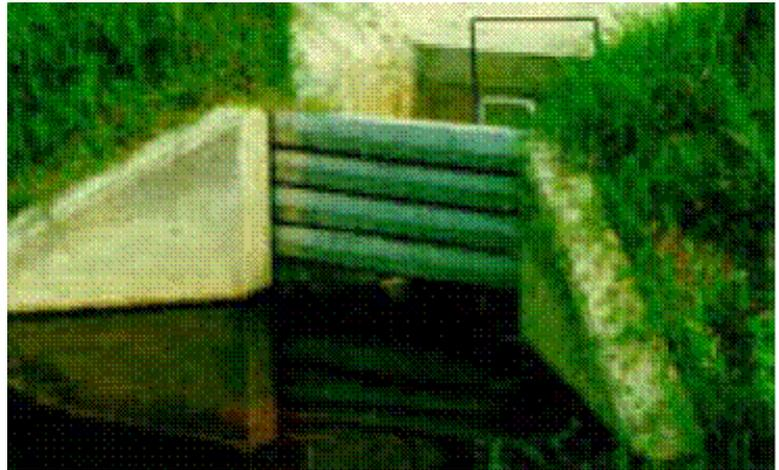
圖 10 出流閘門結構利用水位控制達到調節水力停留時間
