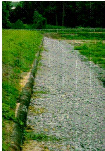
圖 11 利用橫跨濕地單元的穿孔管線來分配入流污水，上有碎石。
