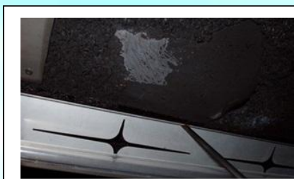
剛開始安裝分解器油脂佈滿煙罩
